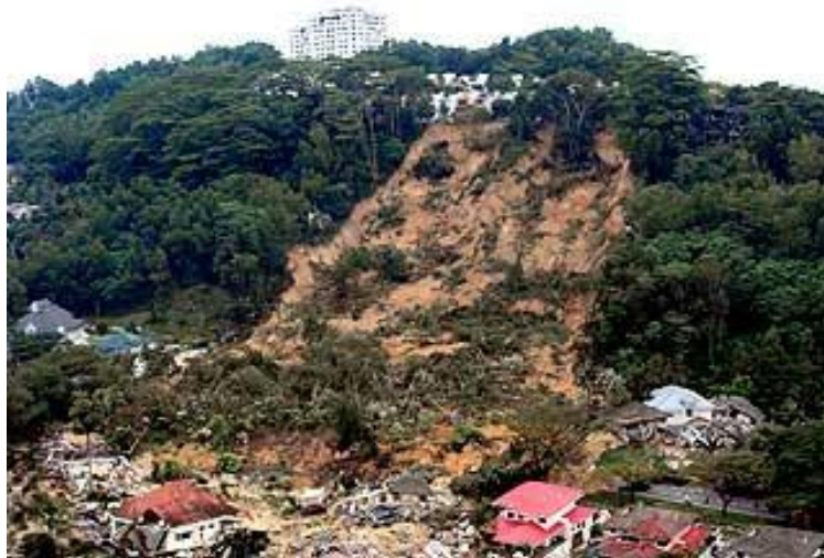
Rajah 1 Kegagalan cerun yang menyebabkan tanah runtuh yang berlaku di Bukit Antarabangsa
