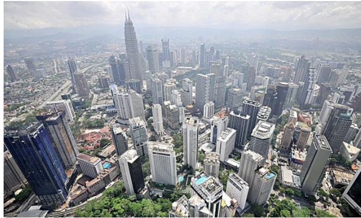
Gambar 1: Susunan bangunan yang tidak seragam
