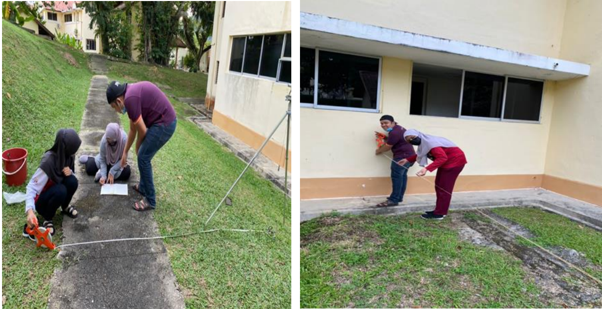
Gambar 3: Ahli kumpulan membuat pemilihan garisan ukur rantai dan membuat pengukuran dengan menggunakan pita linen dari stesen A-B, B-C dan C-D serta membuat ukuran bagi butir-butir yang berdekatan
