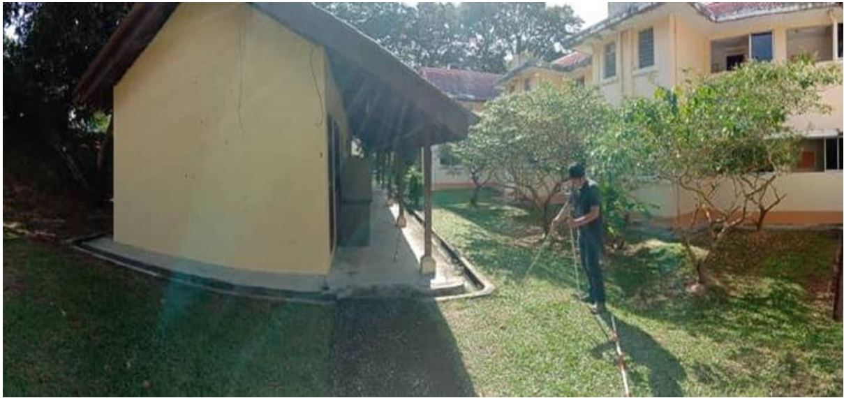
Gambar 1: Kumpulan kami telah memilih stesen ukur rantai iaitu bangunan pensyarah PPIK USM yang mempunyai kesalingnampakan dan kebolehsampaian yang baik
